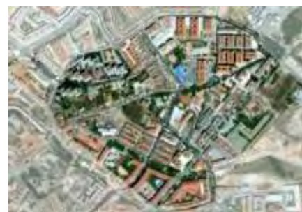
Fig.12. Vista aérea Alamín
